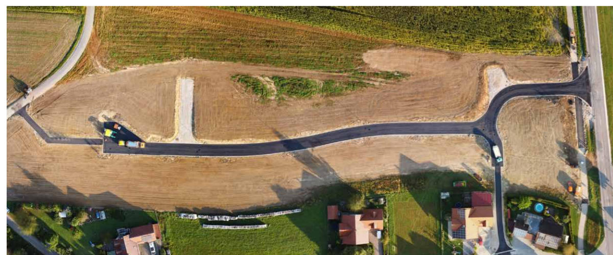
Erschließung des Baugebiets Aichen © Konstruktionsgruppe Bauen
