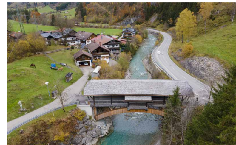
Ostrachbrücke Bruck, Bad Hindelang © Konstruktionsgruppe Bauen
